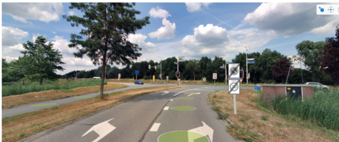
Flespaal plaatsen en verkeersborden E1-ZE en A1-30 ZE plaatsen.
